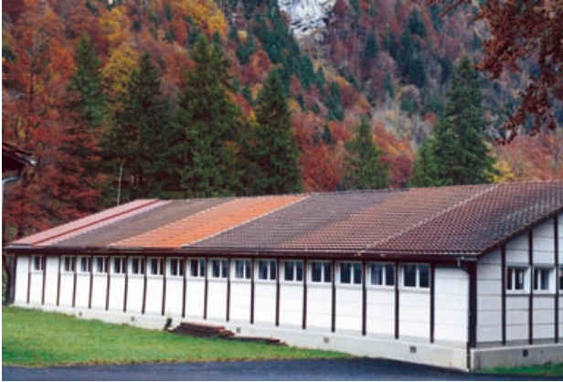
Eine mit verschiedenen Dachziegeln eingedeckte Baracke im Frühherbst und Winter A barracks clad with various clay roofing tiles in the early autumn and winter
