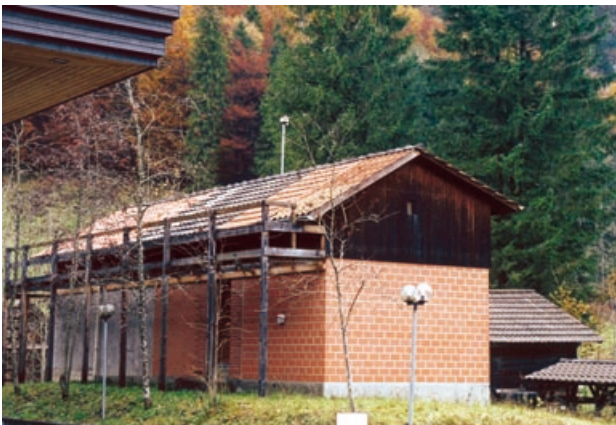
Die Versuchsstation, eingedeckt mit Musterziegeln, im Frühherbst und Winter – der Messfühler für die Klimadatenerfassung befindet sich circa einen Meter oberhalb des Dachfirstes
