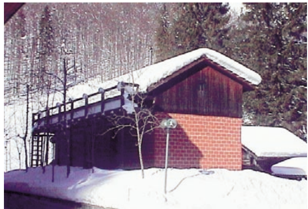
Die Versuchsstation, eingedeckt mit Musterziegeln, im Frühherbst und Winter – der Messfühler für die Klimadatenerfassung befindet sich circa einen Meter oberhalb des Dachfirstes
